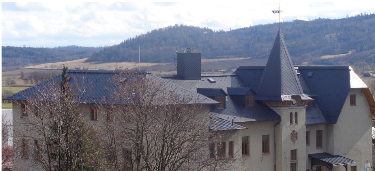
Odstranění havarijního stavu střechy – září 2016 až leden 2017
