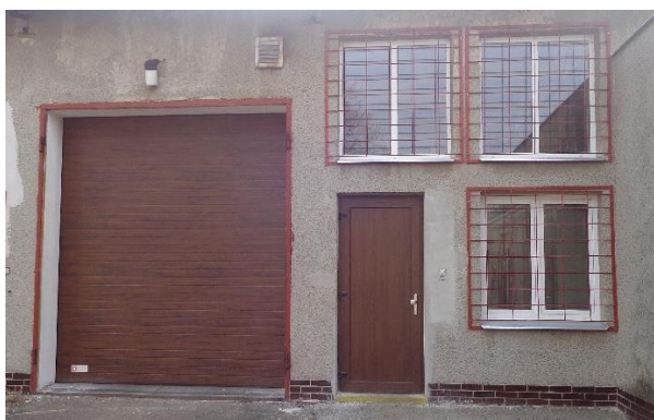
Výměna vrat a oken v budově dílen OV – listopad 2016
